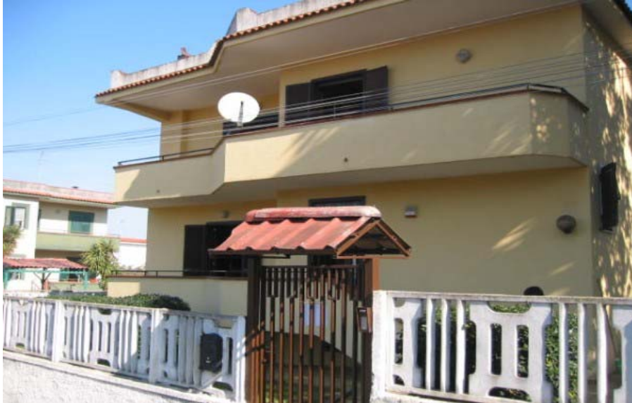
Foto 1.1 - Visuale esterna della struttura
