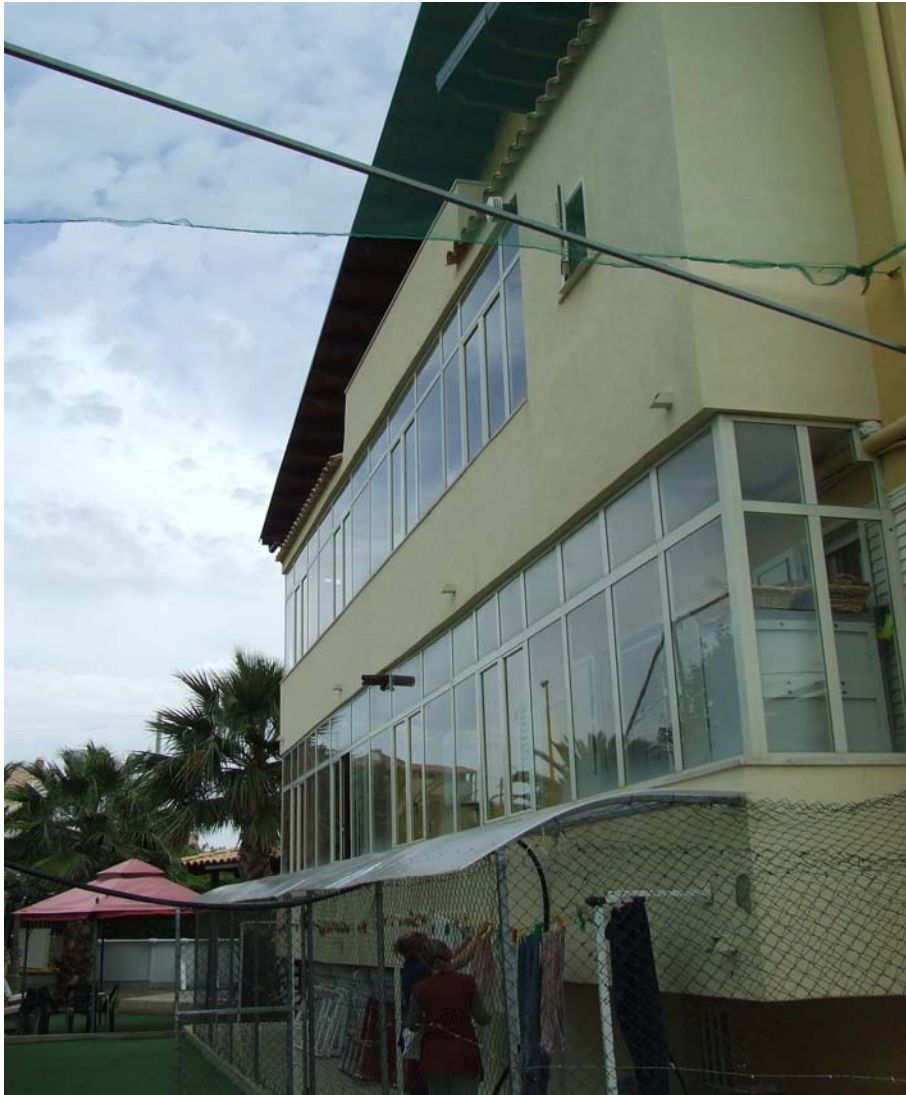
Foto 4.1 - Visuale esterna della struttura
